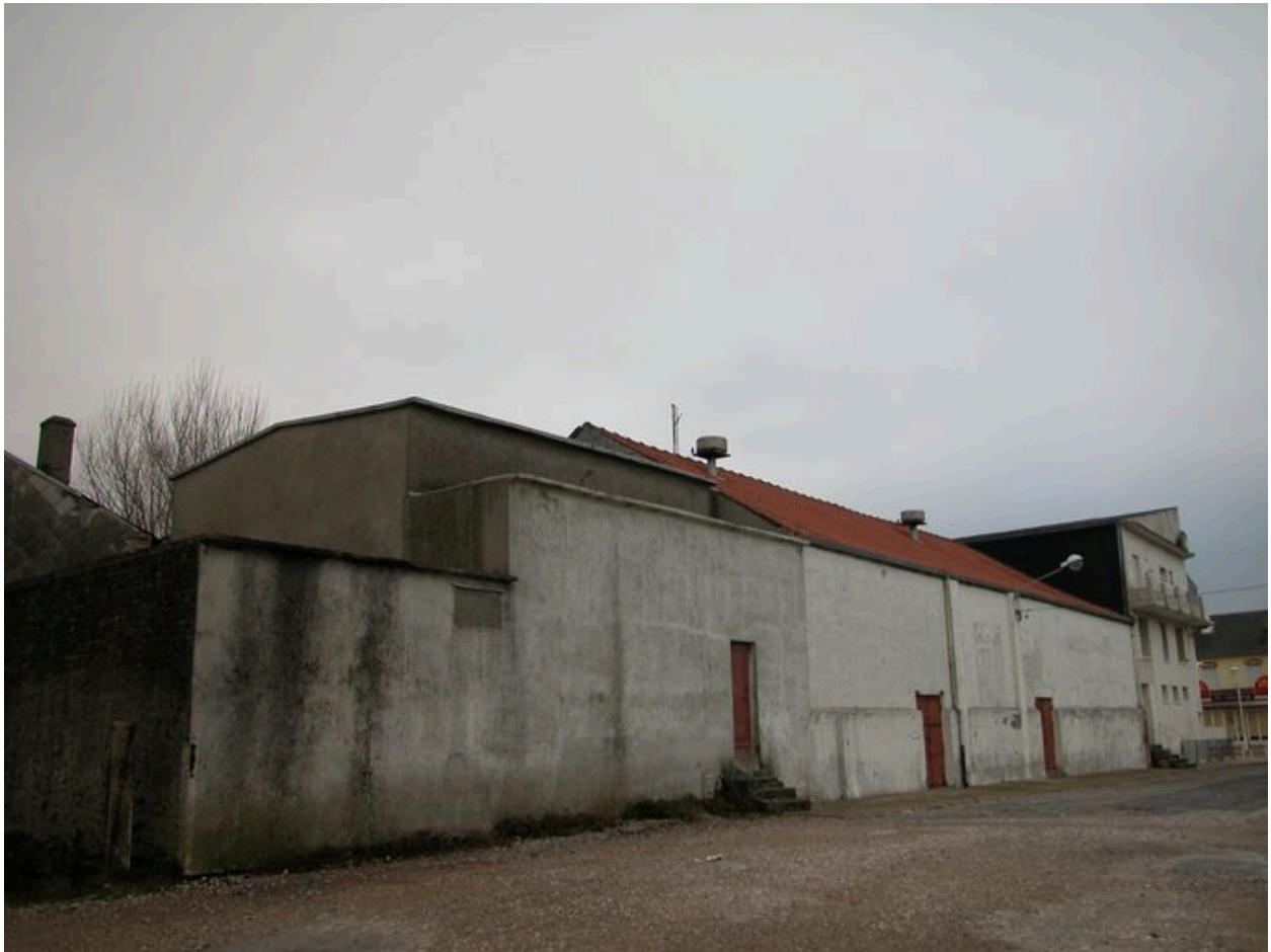
Vue d'ensemble des bâtiments depuis la rue de la Tour.
