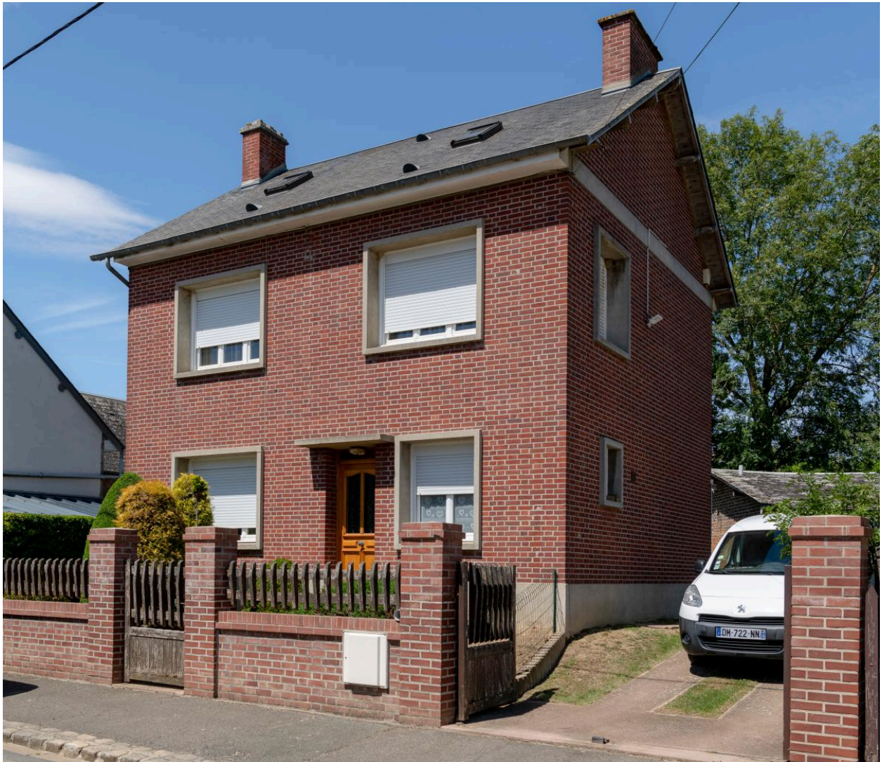
Logis construit dans les années 1950, n°6 rue de la Gare, vue depuis le sud-est.
