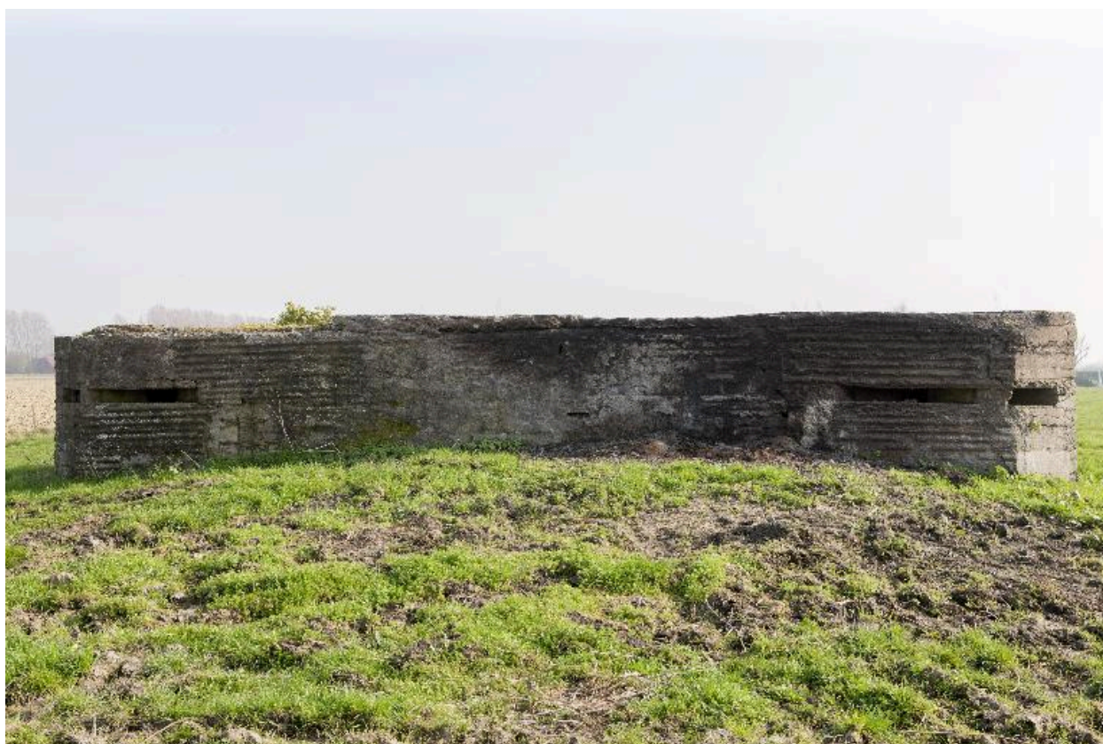
Elévation nord, sur le front.
