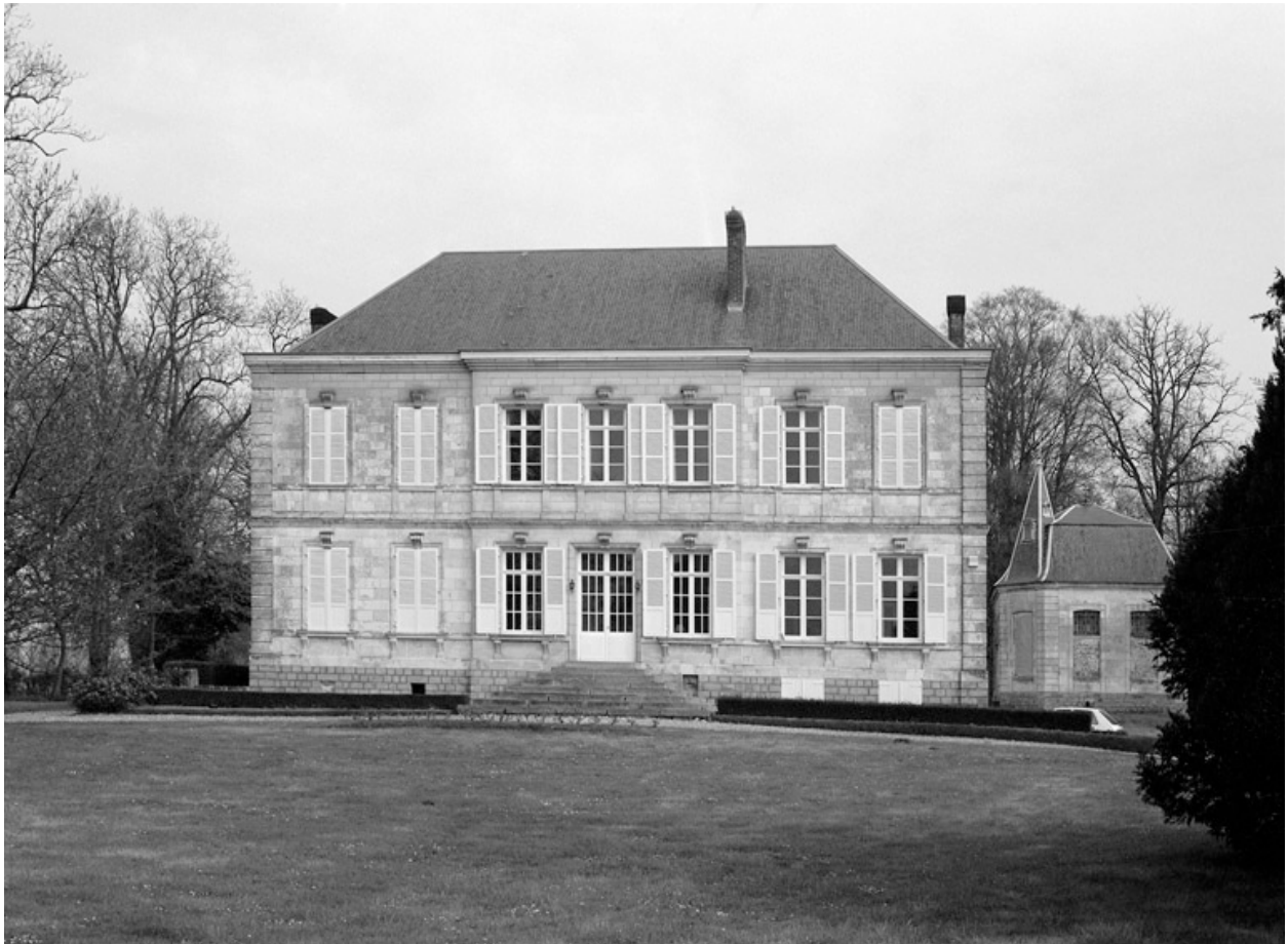
Vue d'ensemble, le corps du logis et la chapelle.
