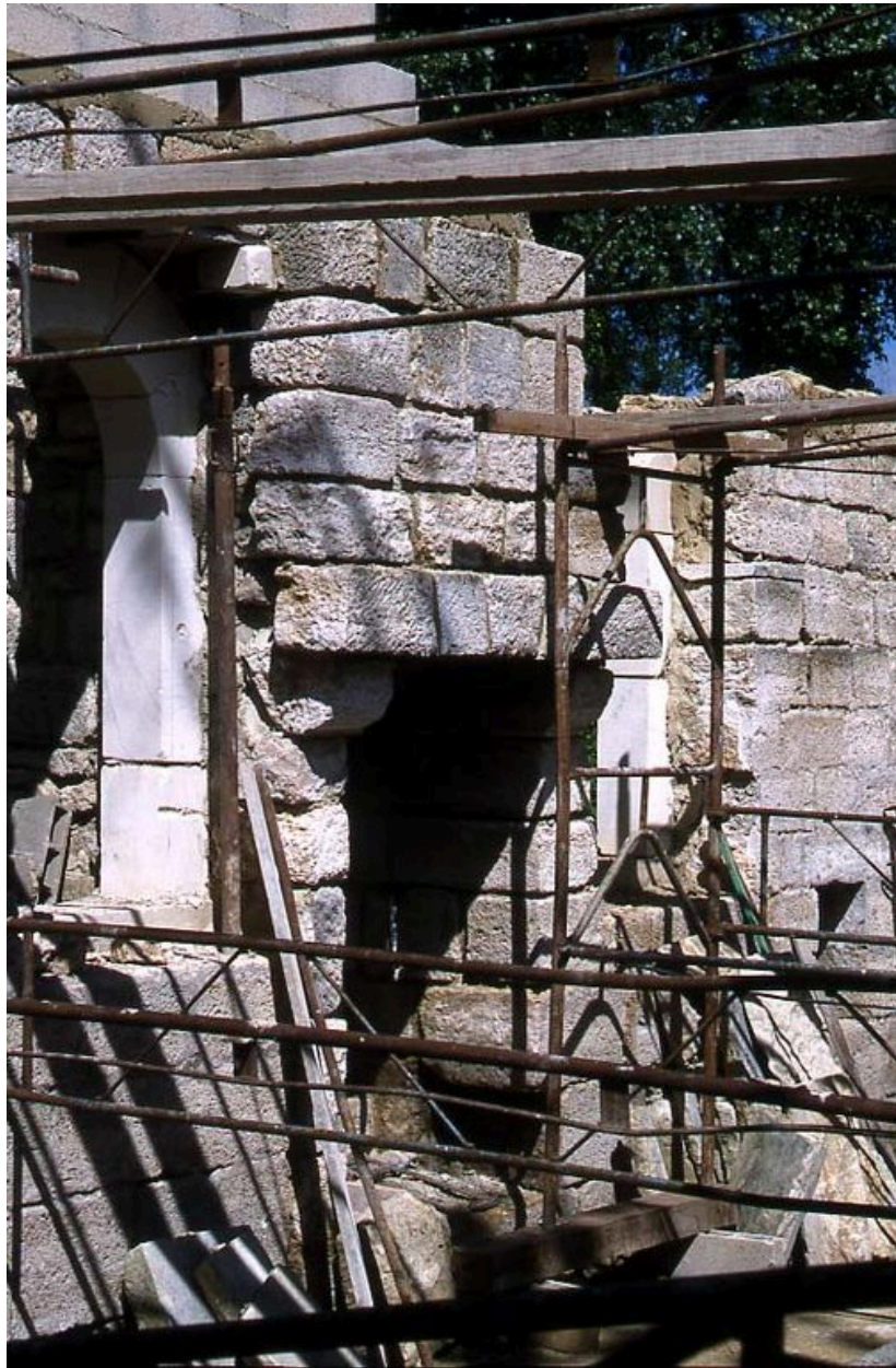
Vue d'un pan de mur en reconstruction.
