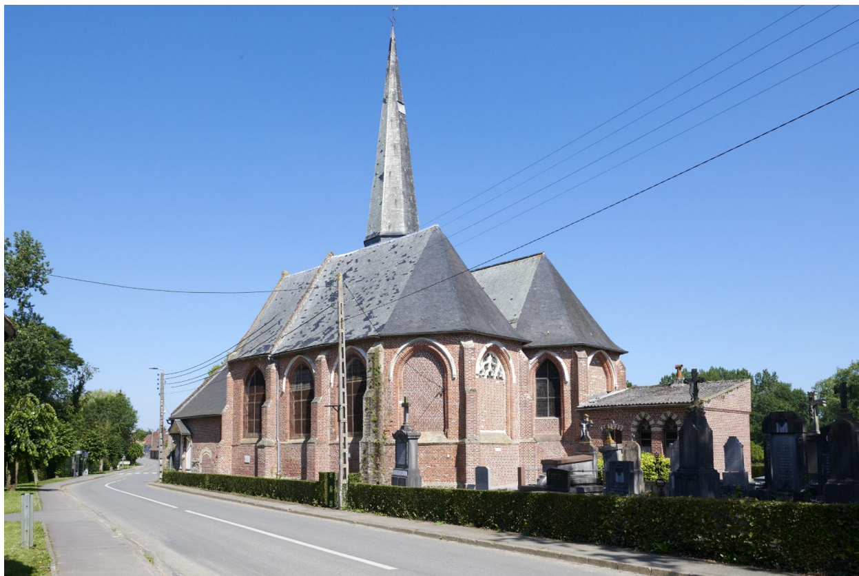
Vue de l'église depuis la rue Principale.
