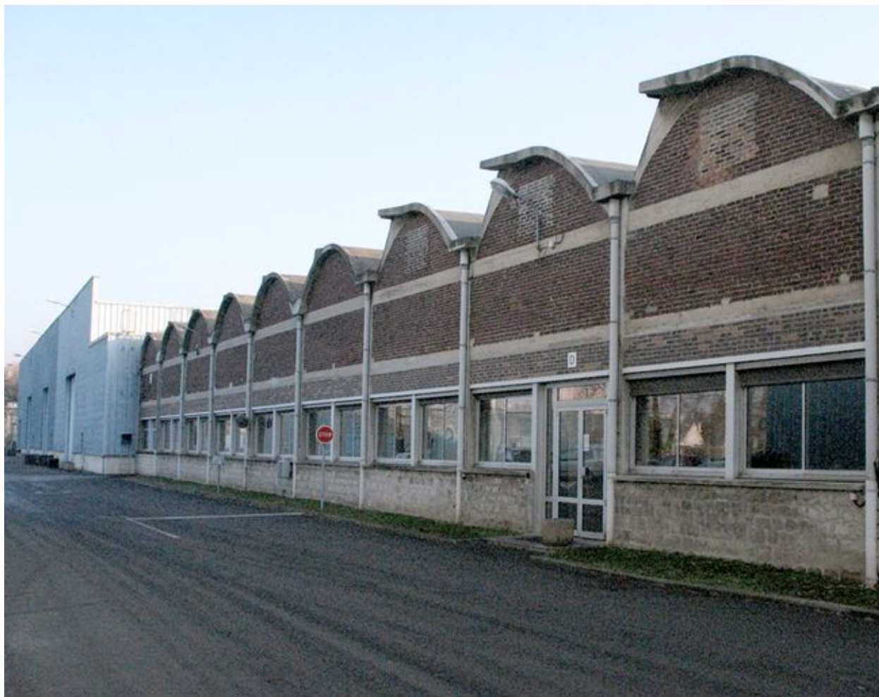
Elévation des ateliers couverts de sheds ovoïdes en béton.
