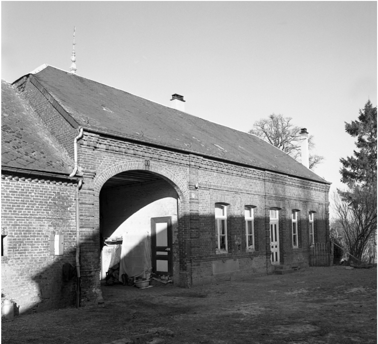
Élévation sur cour du logis et passage menant à l'extérieur.
