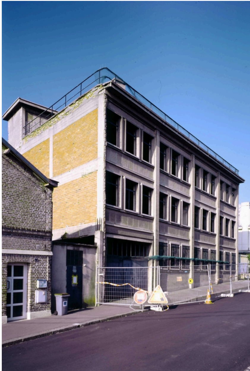
Façade antérieure de la chaufferie, rue Jacquard.
