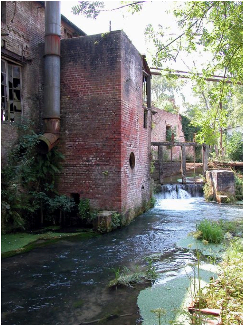
Le vannage de décharge et l'ancienne salle des machines.
