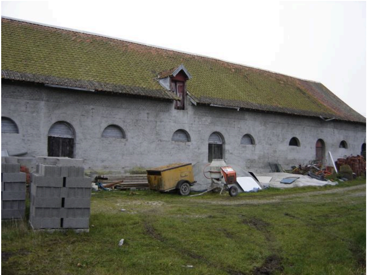
Vue sur l'étable depuis le sud-est.
