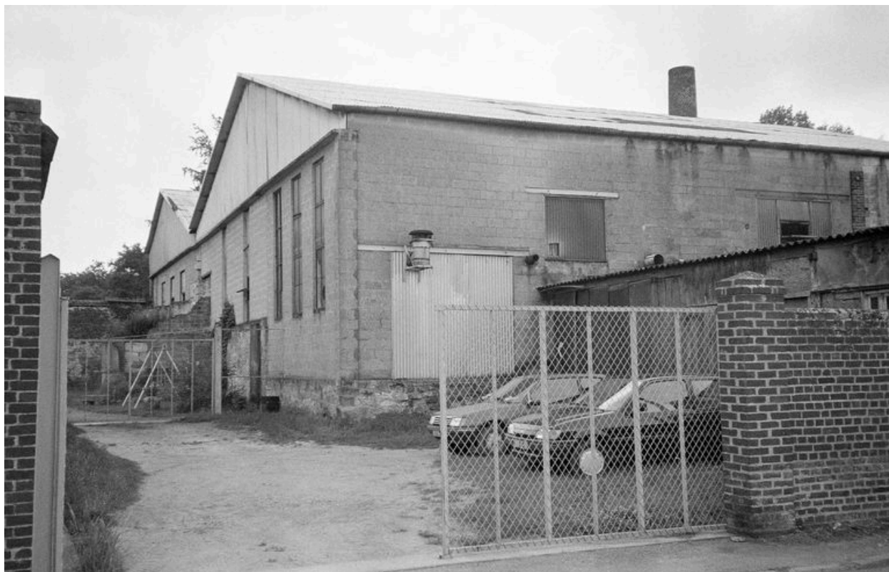
Vue générale : flanc ouest.
