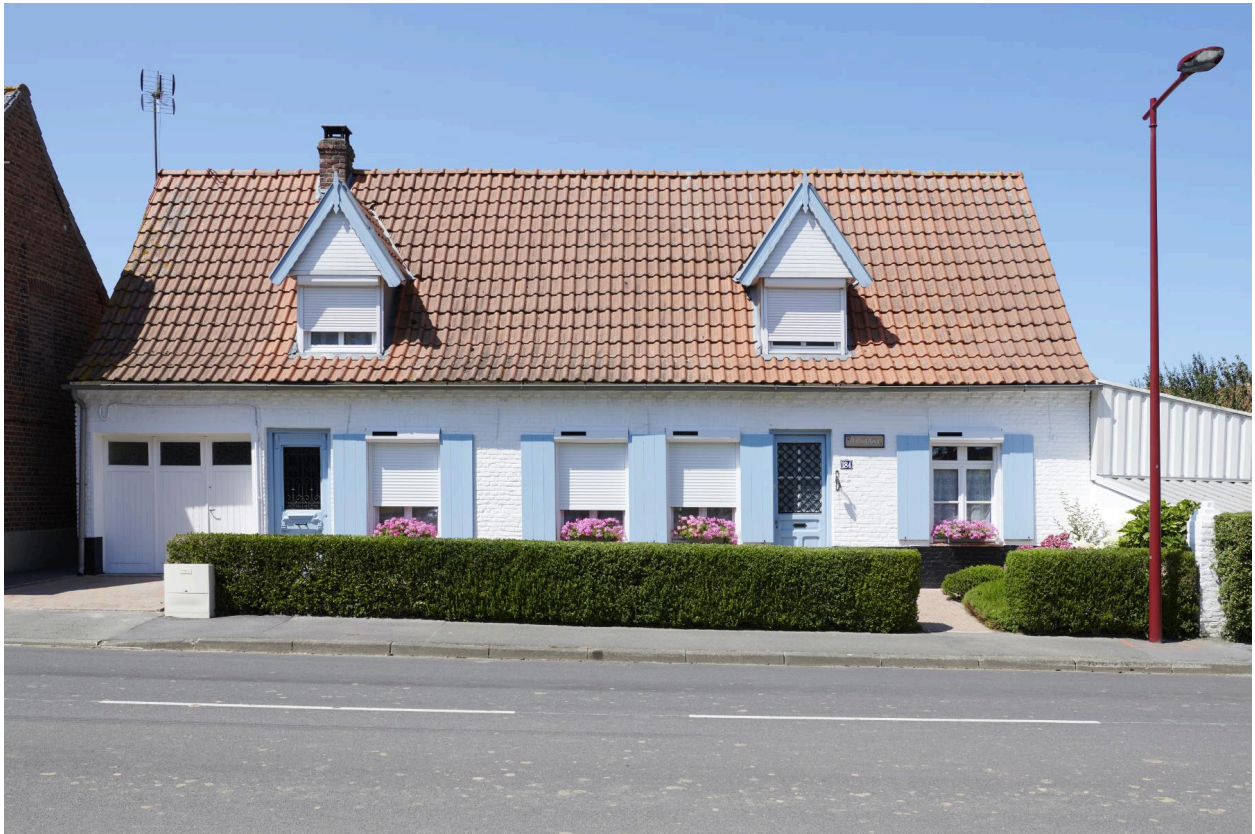
Vue générale de la façade principale sur rue.
