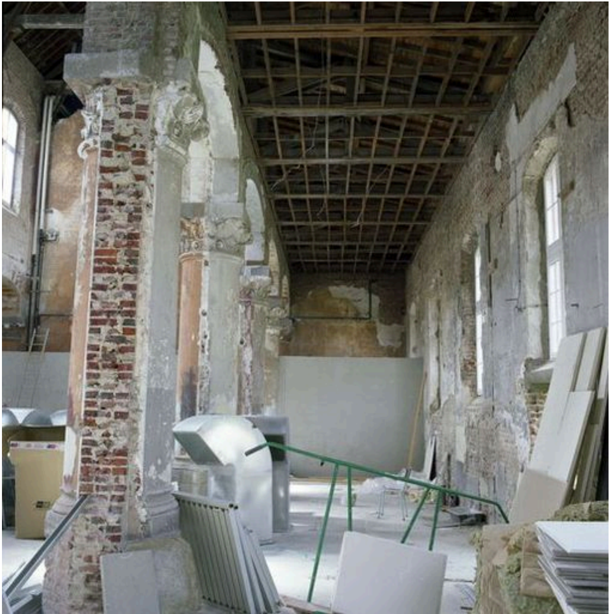
Chapelle, bas-côté nord, vue axiale en regardant vers l'entrée.
