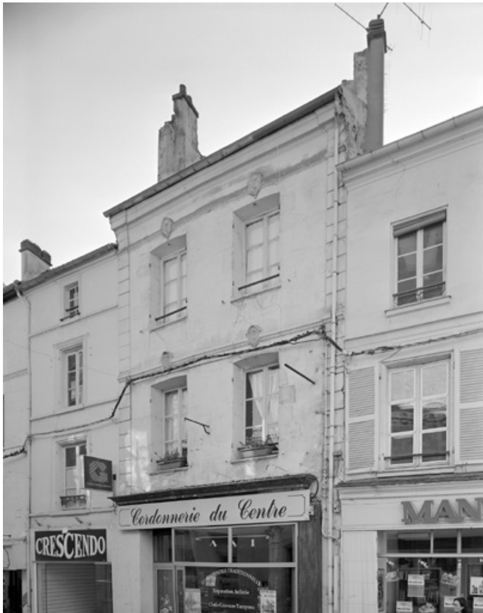
Maison, 68 Grande-rue. Élévation sur la rue.
