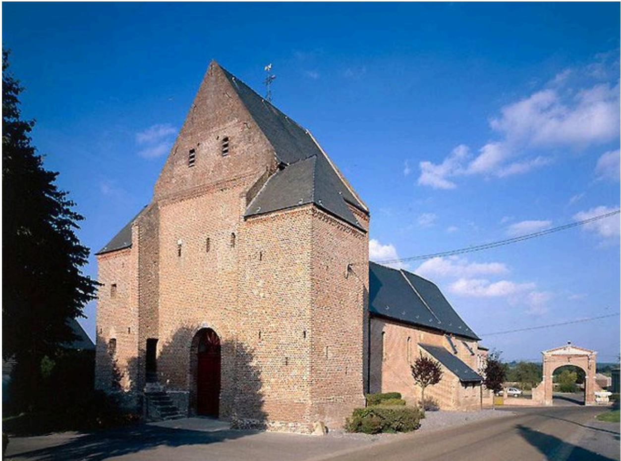
Vue depuis le sud-ouest.
