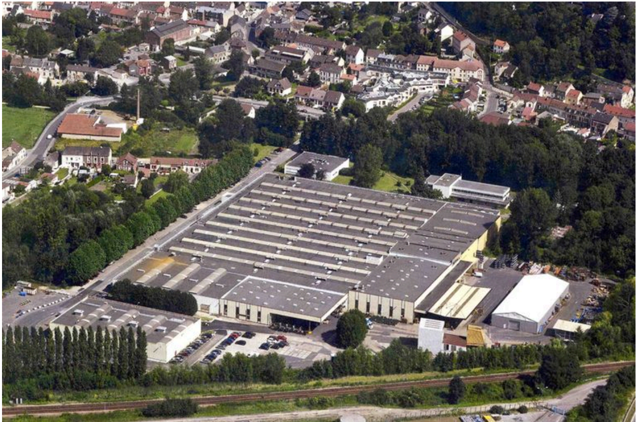
Vue aérienne de l'usine Still à Montataire.
