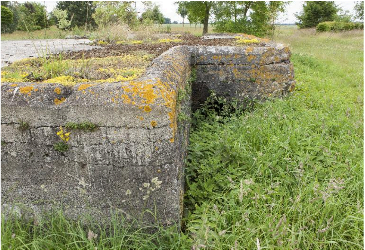
Angle nord-est de la casemate ouest
