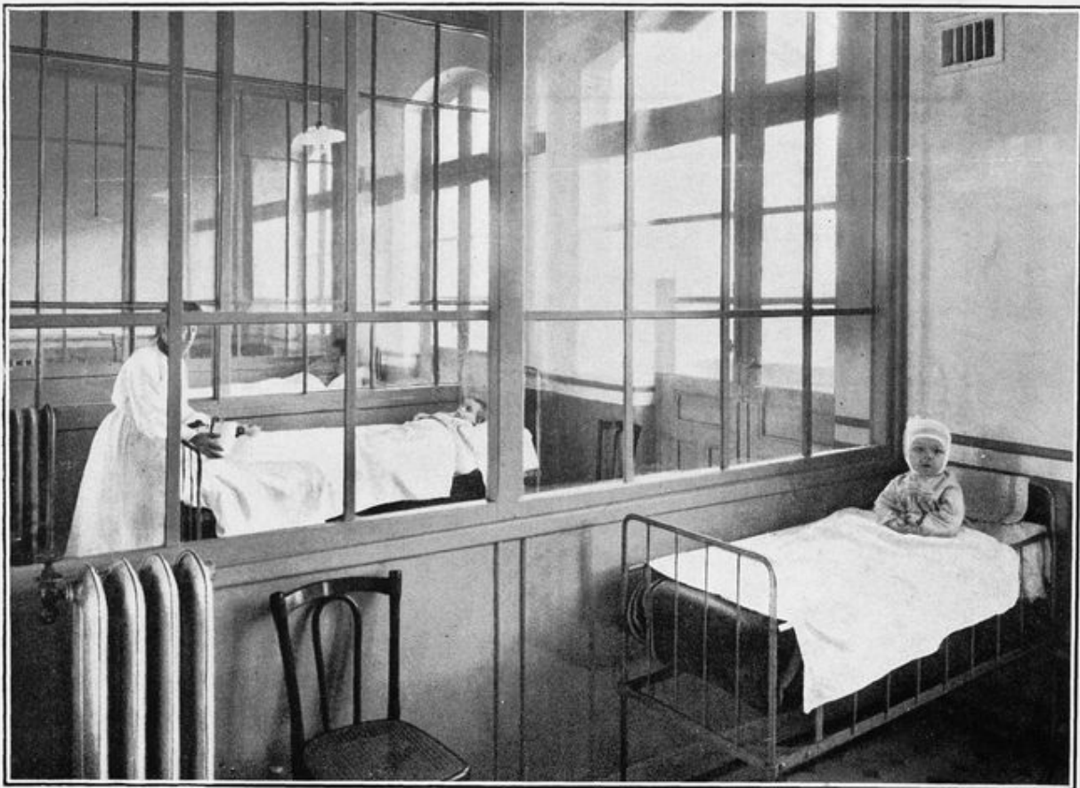
VUE INTÉRIEURE D'UN DES PAVILLONS D'ISOLEMENT ET D'OBSERVATION
