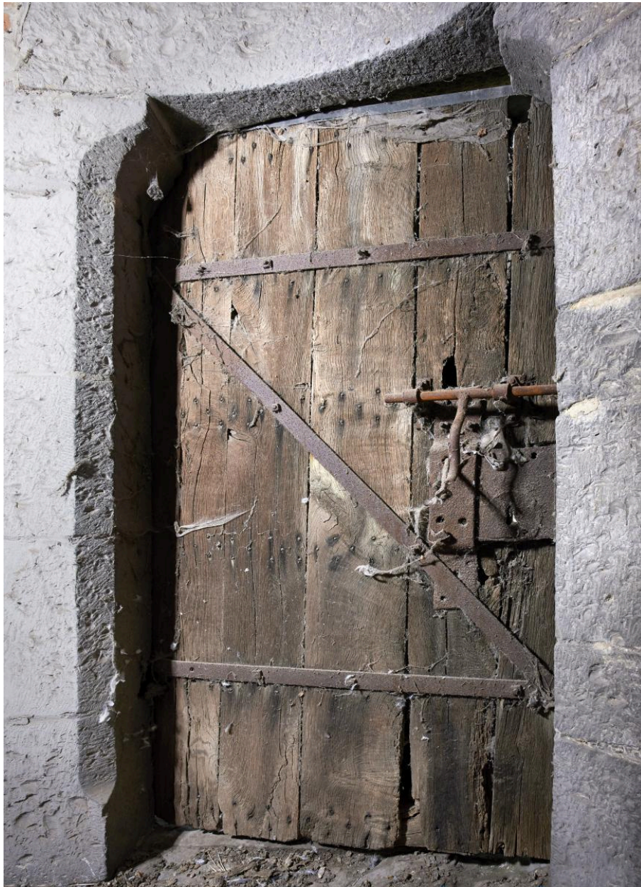
Porte du niveau "intermédiaire" donnant sur l'ancienne courtine. Traitement architectural de l'encadrement en grès.
