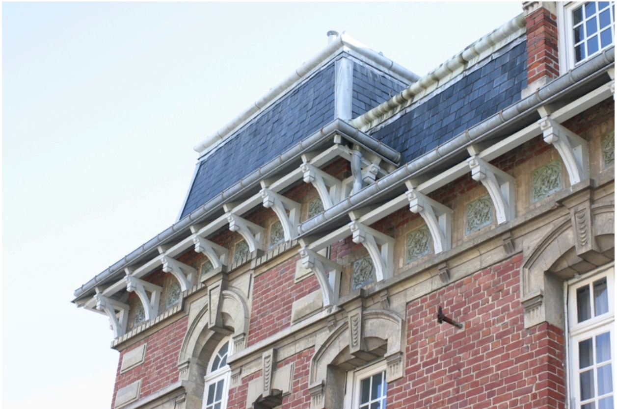
Le logement patronal : détail.
