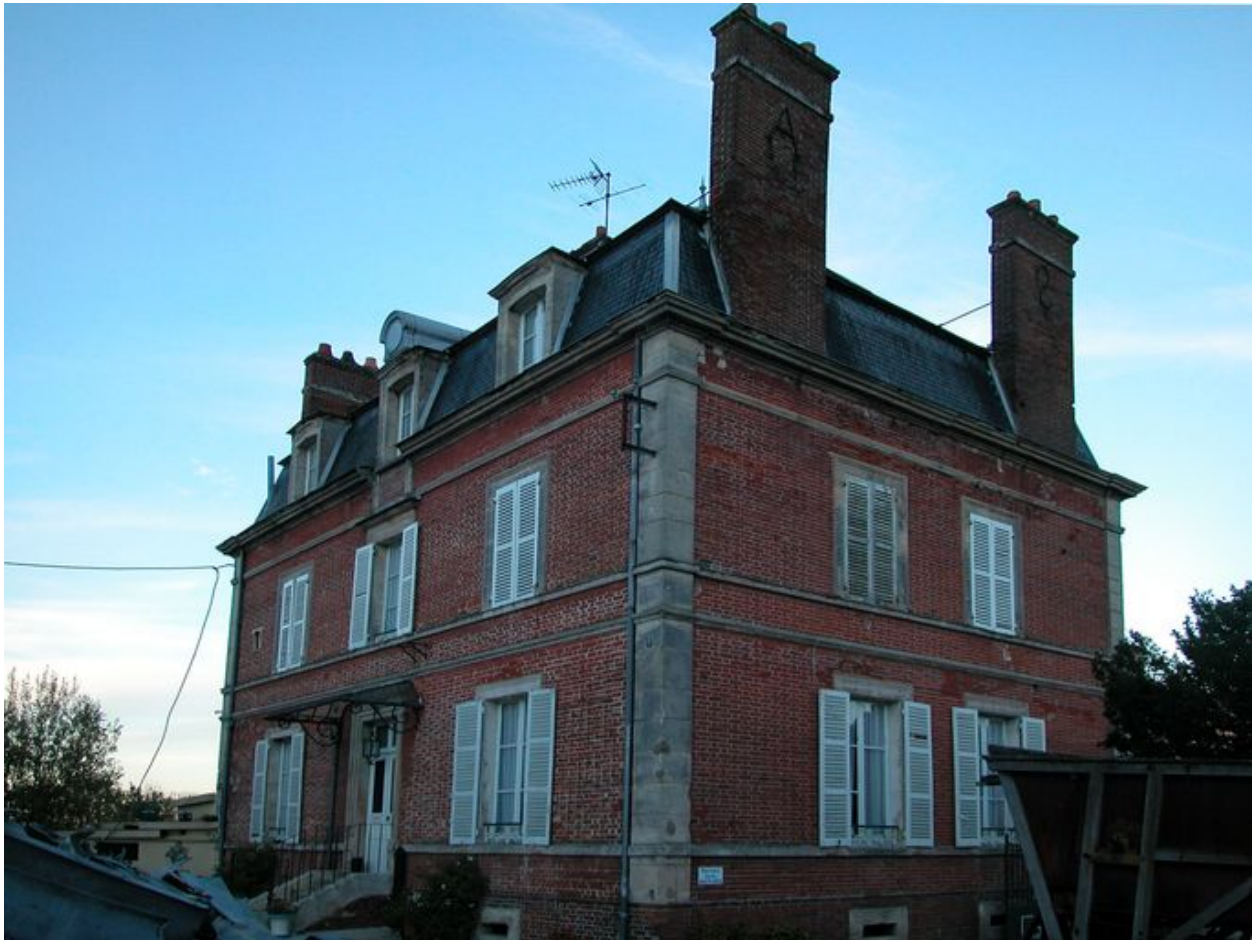
Le logement patronal, vue d'ensemble sud-ouest.
