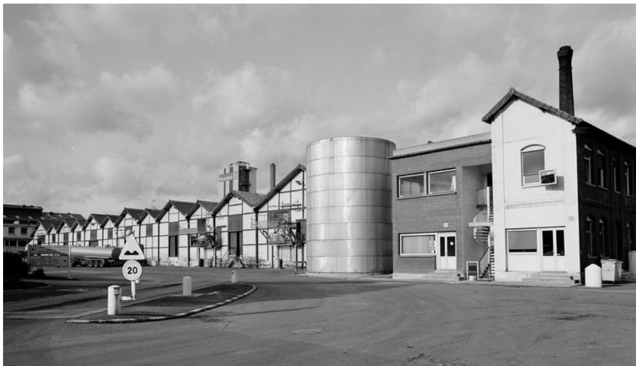
Atelier de fabrication construit en 1895-1896.
