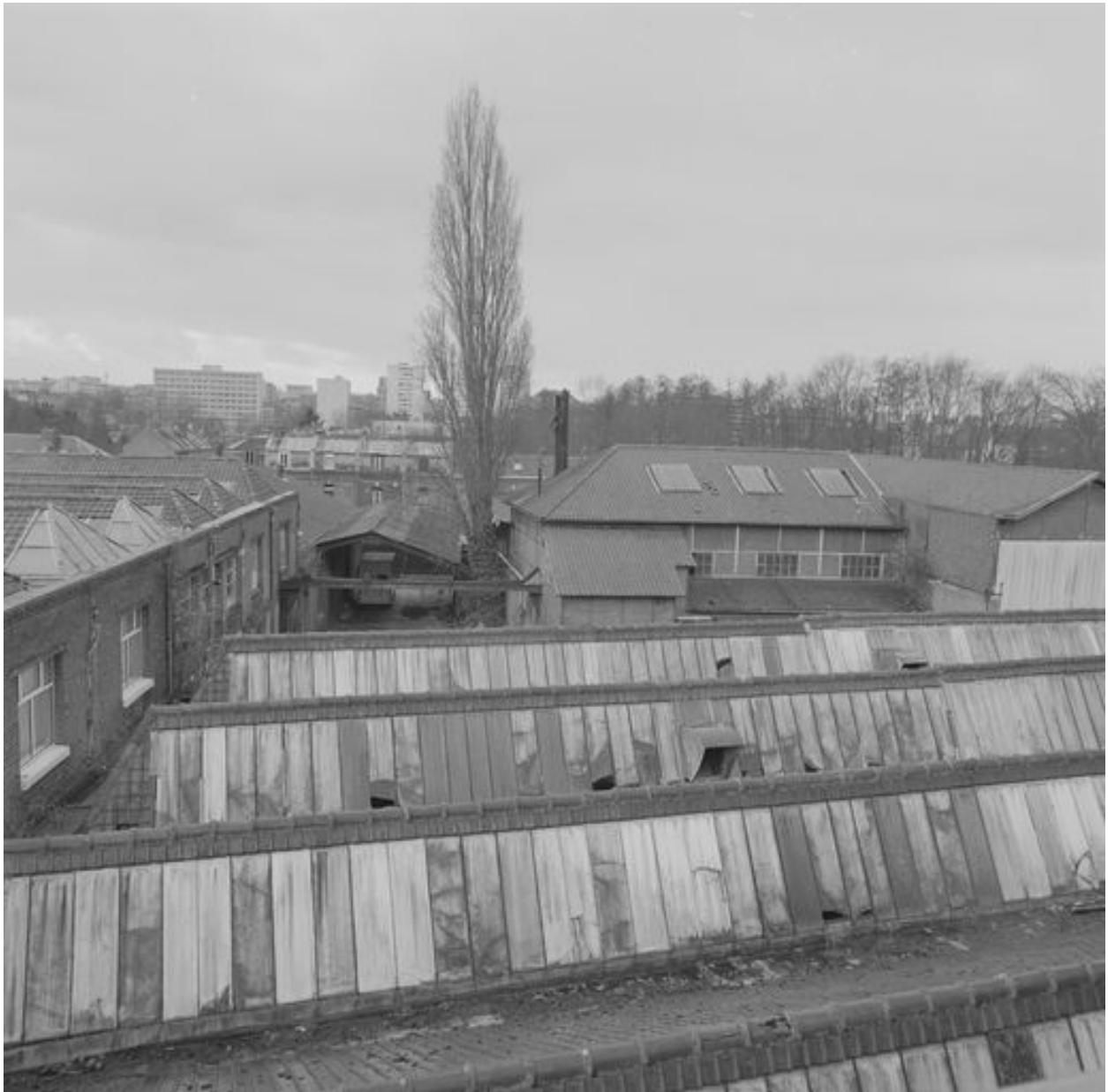
Vue des toitures.
