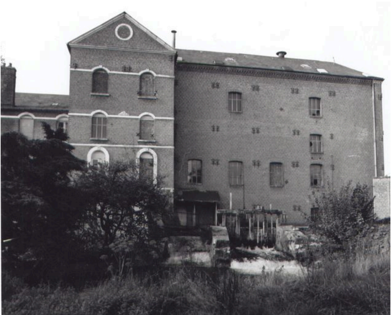
Façade postérieure de la minoterie.
