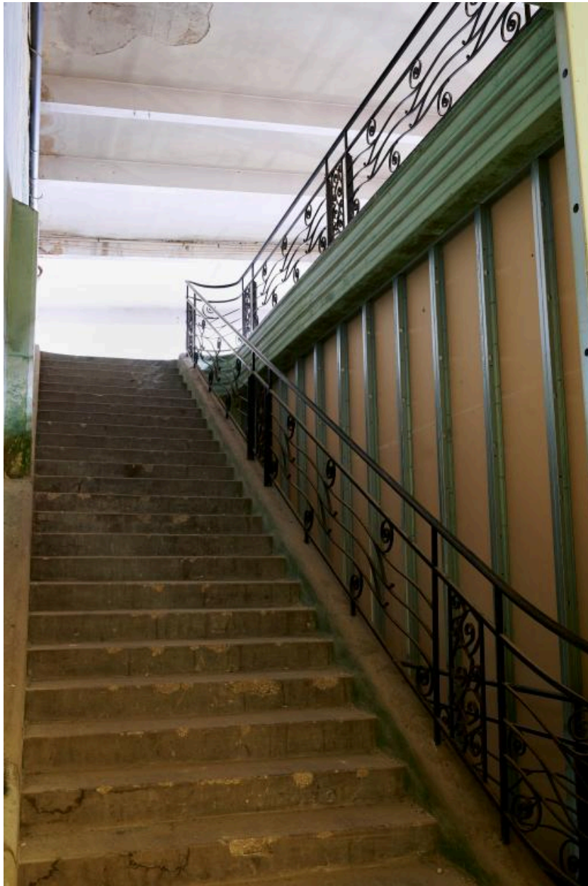
Rampe d'escalier en béton armé desservant le dernier étage du magasin.
