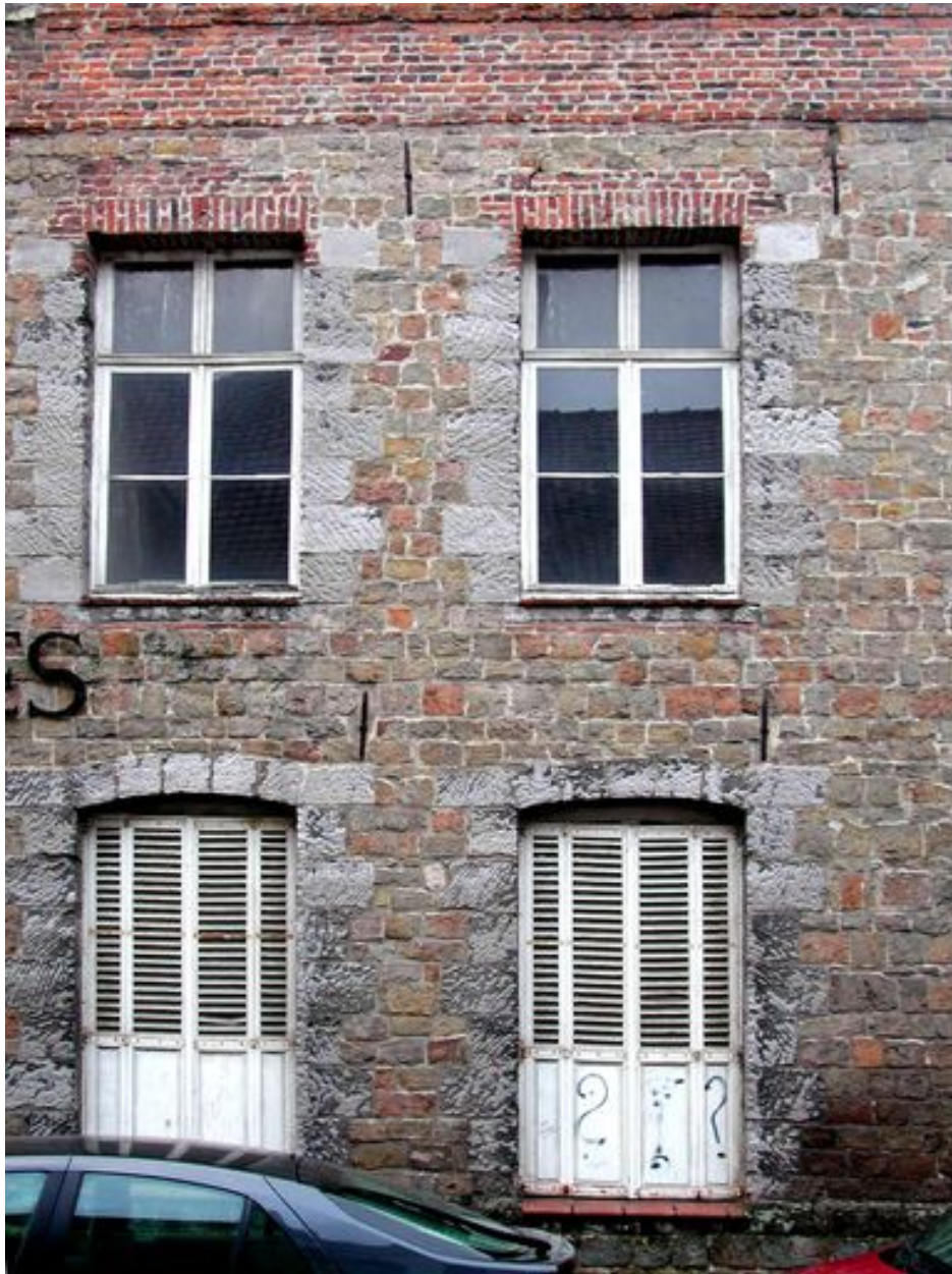
Façade rue Notre-Dame, vue partielle : maçonnerie de grès, calcaire, brique.
