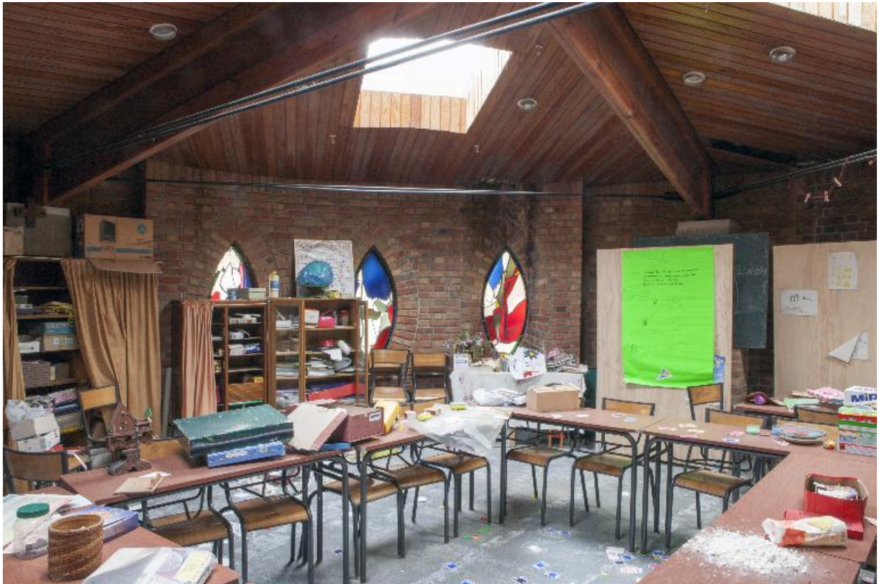
Vue de la salle de catéchisme.
