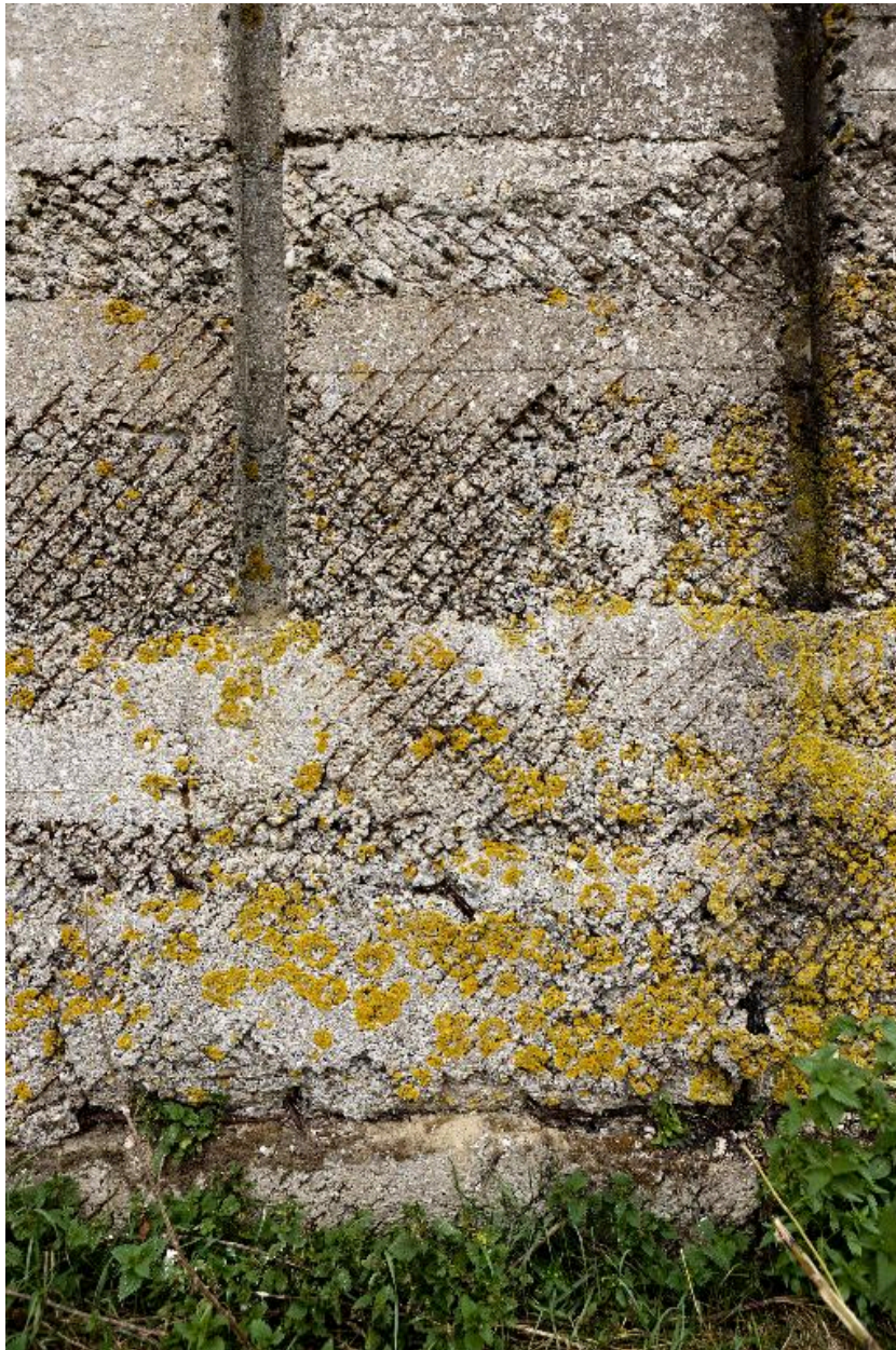
Détail du pignon est. Grillage de coffrage ?
