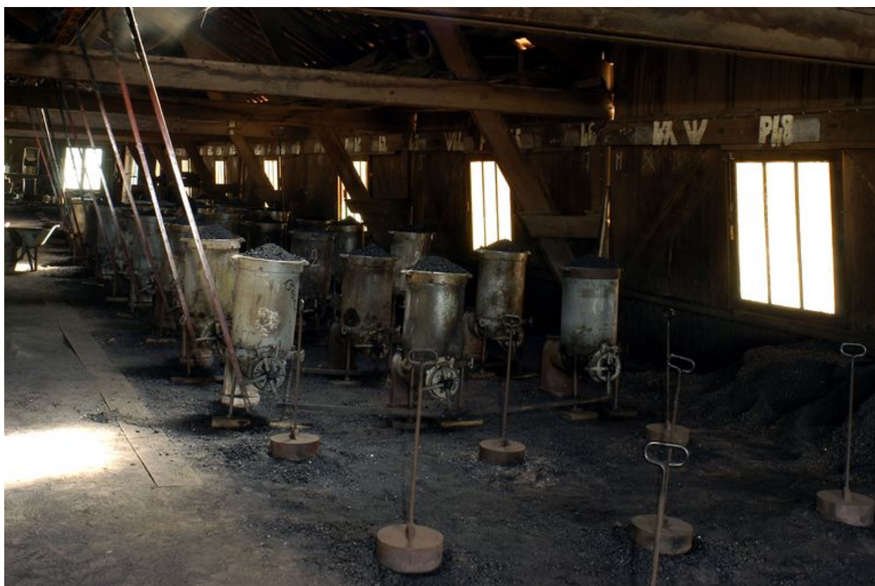
Vue des marmites à charbon, au-dessus des foyers du four.
