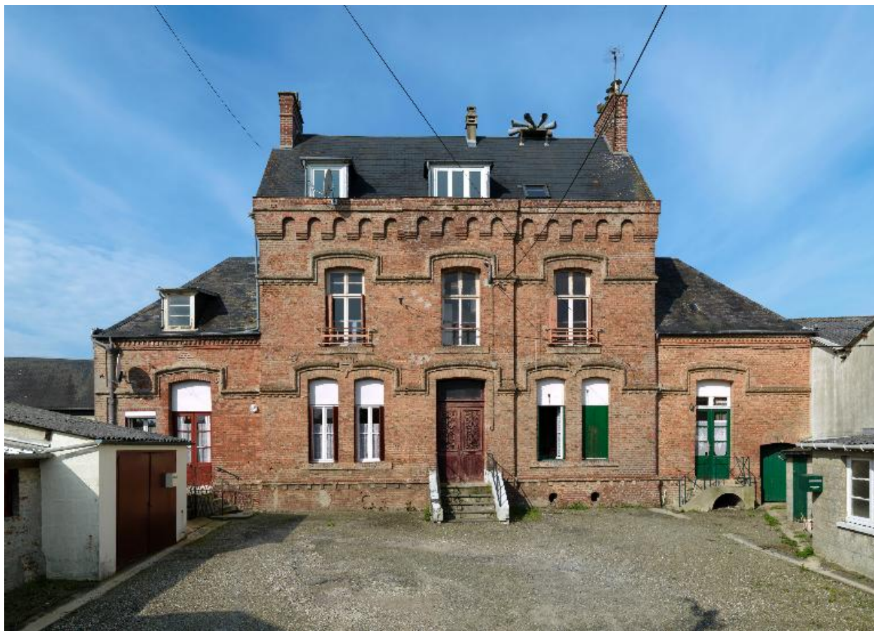
Vue générale depuis la cour.
