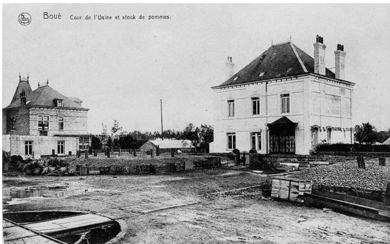
Les deux logements patronaux vus depuis la cour de l'usine, [s.d.] (coll. part.).
