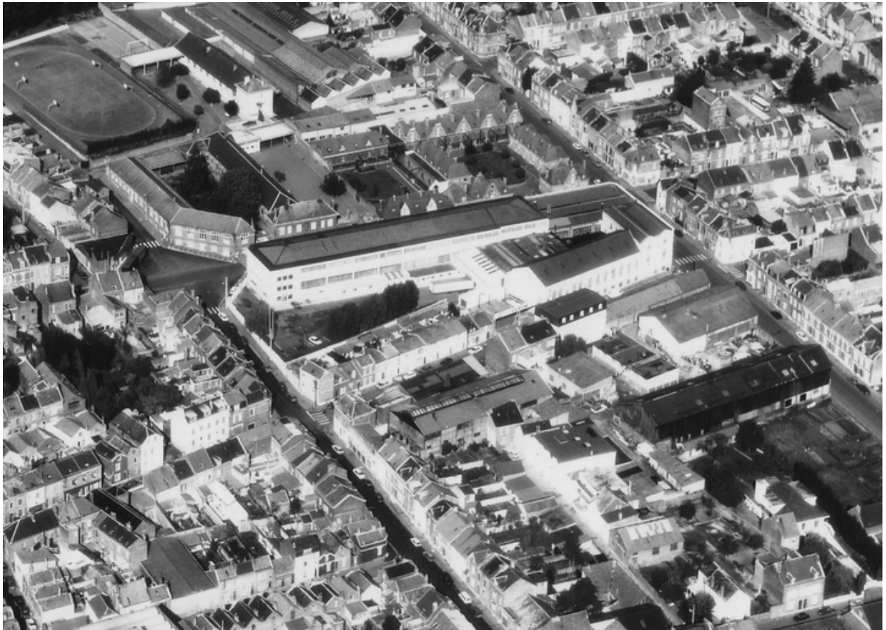
Vue aérienne de l'usine en 1989, prise du sud.
