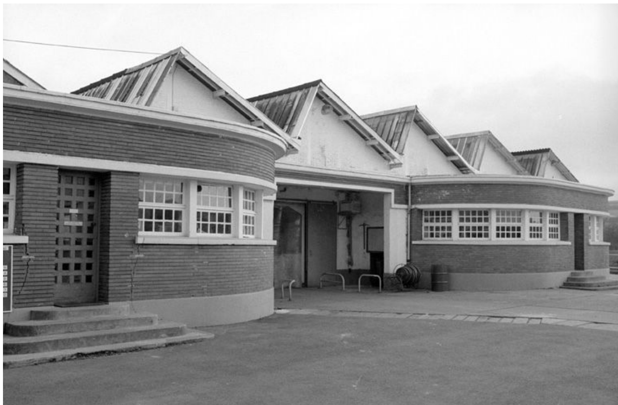
Atelier de fabrication, vue partielle des sheds.
