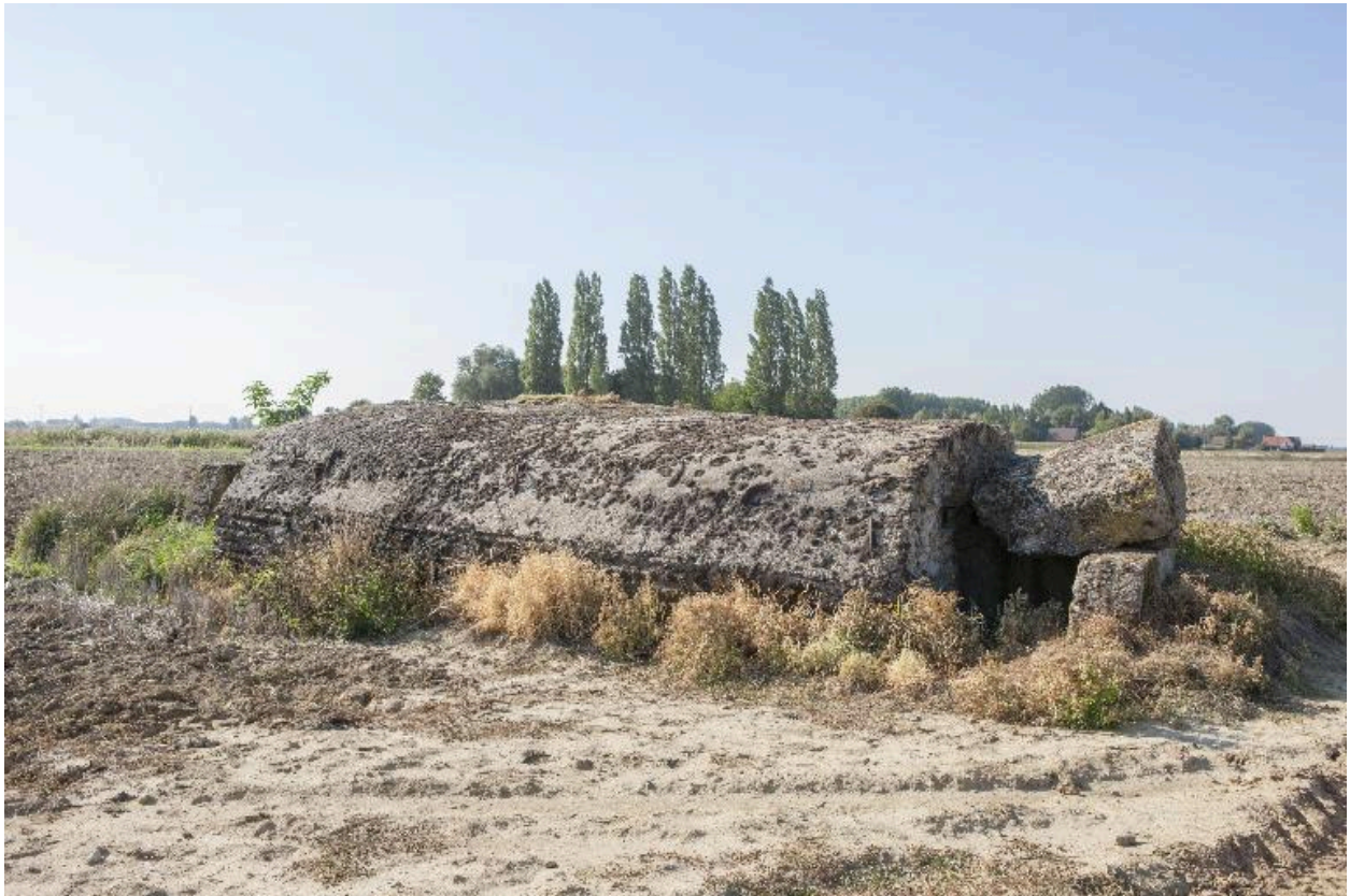
Vue générale vers le nord-ouest
