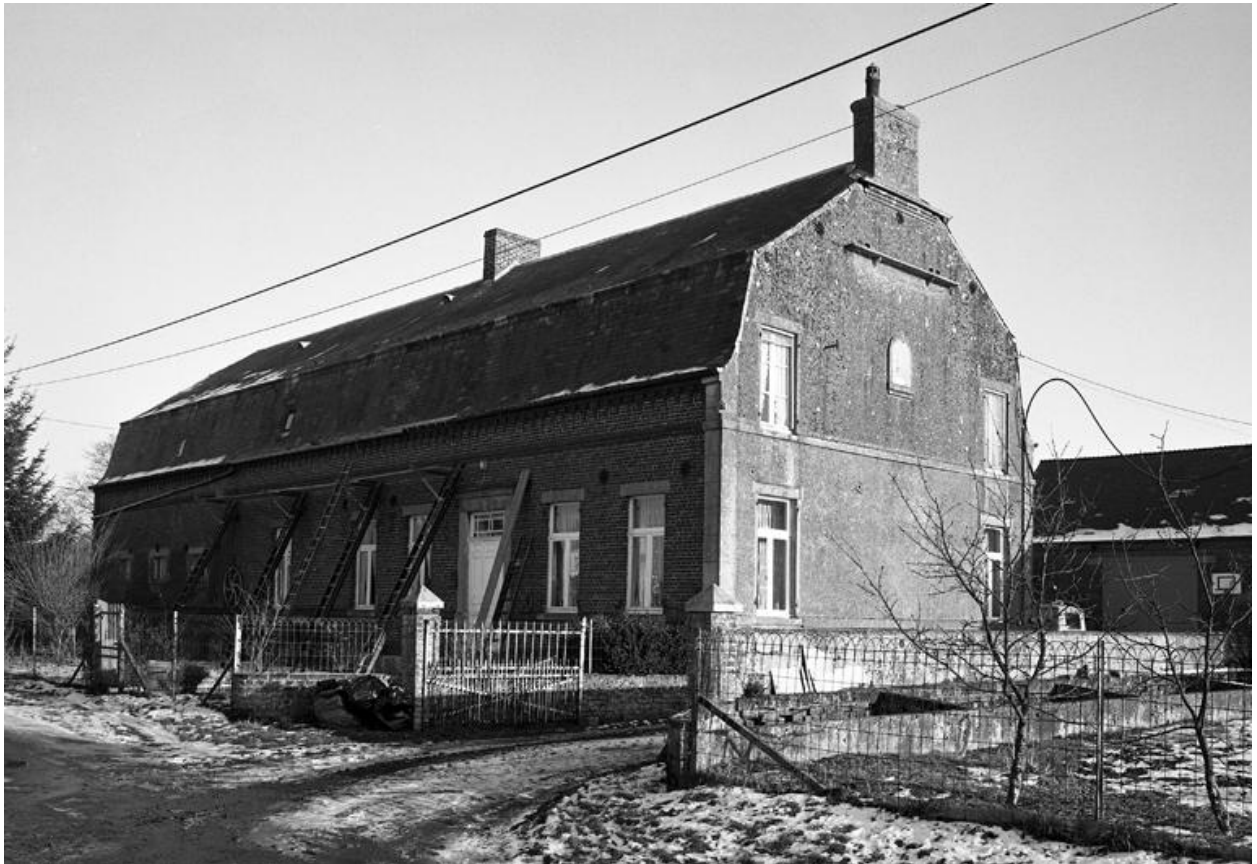
Le logis. Façade postérieure.
