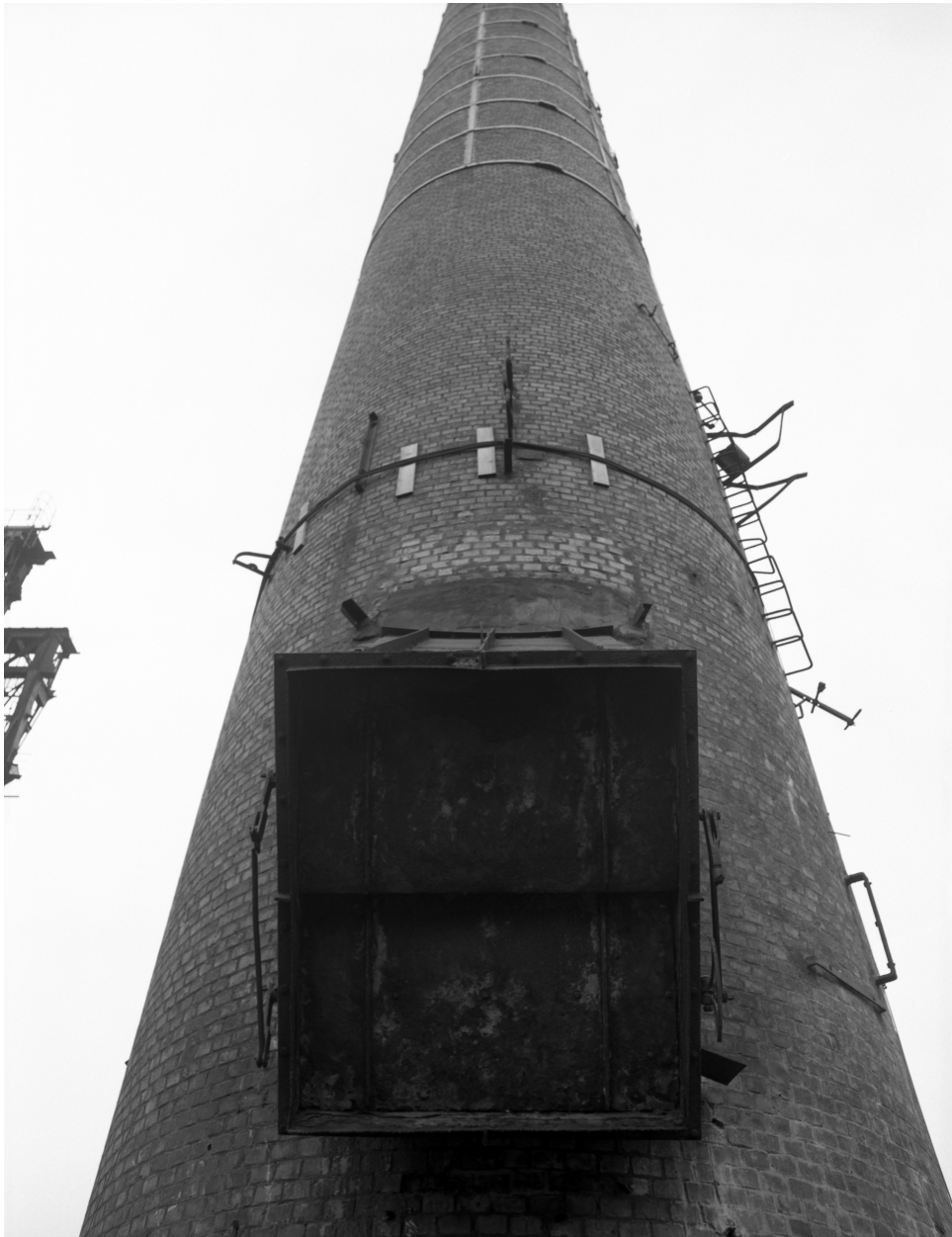
Cheminée d'usine, partie médiane : détail.
