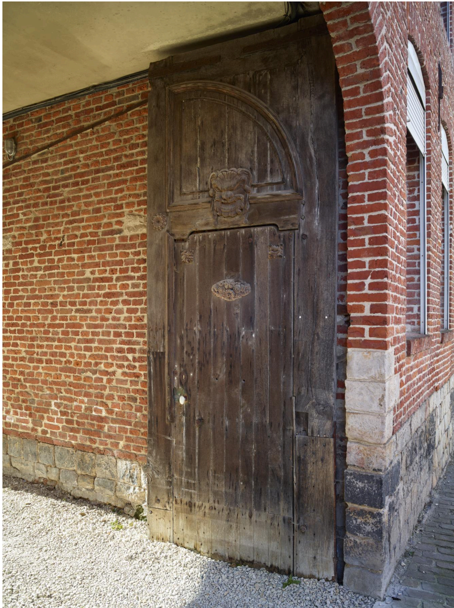
Détail du vantail droit de la porte cochère - n°5, rue de l'Aulette.
