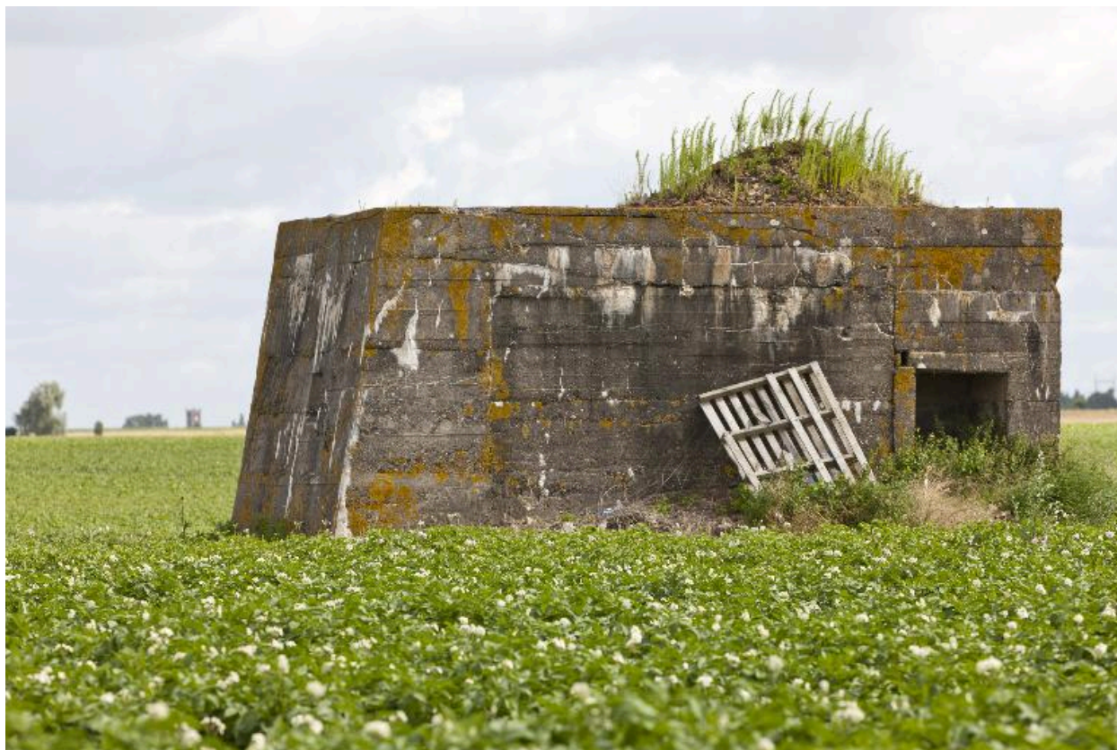
Vue vers le nord-est
