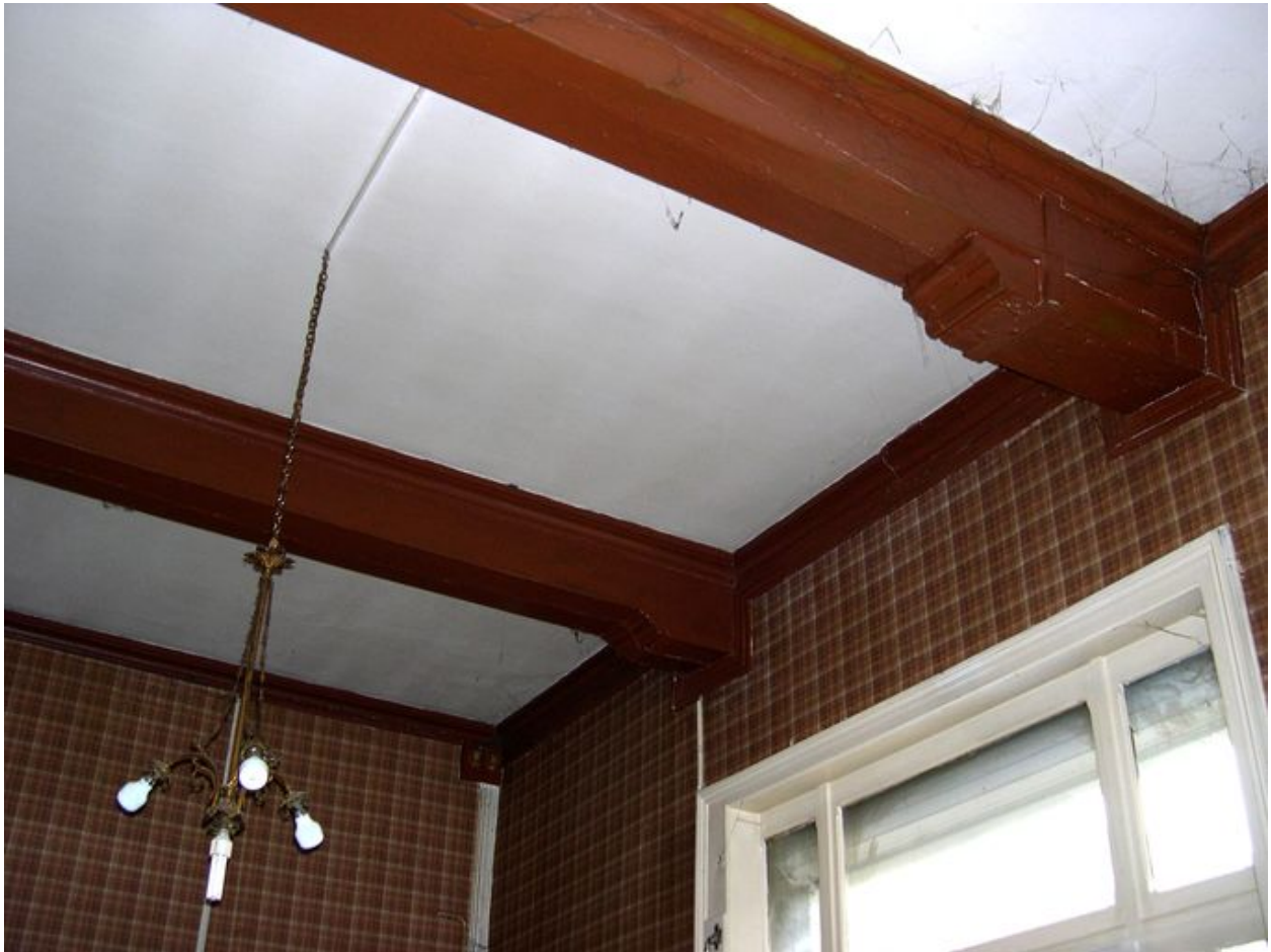
Intérieur, rez-de-chaussée, pièce sud-est : plafond, vue partielle, abouts de poutres moulurés.
