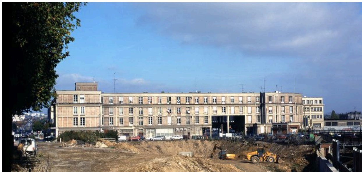
Façade sud de l'immeuble.
