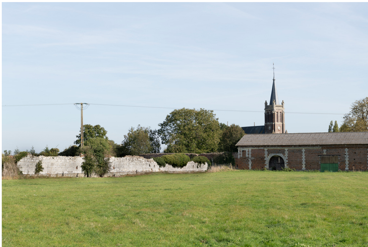
Mur de l'ancien parc du château et bâtiment ouest, vue depuis l'ouest.
