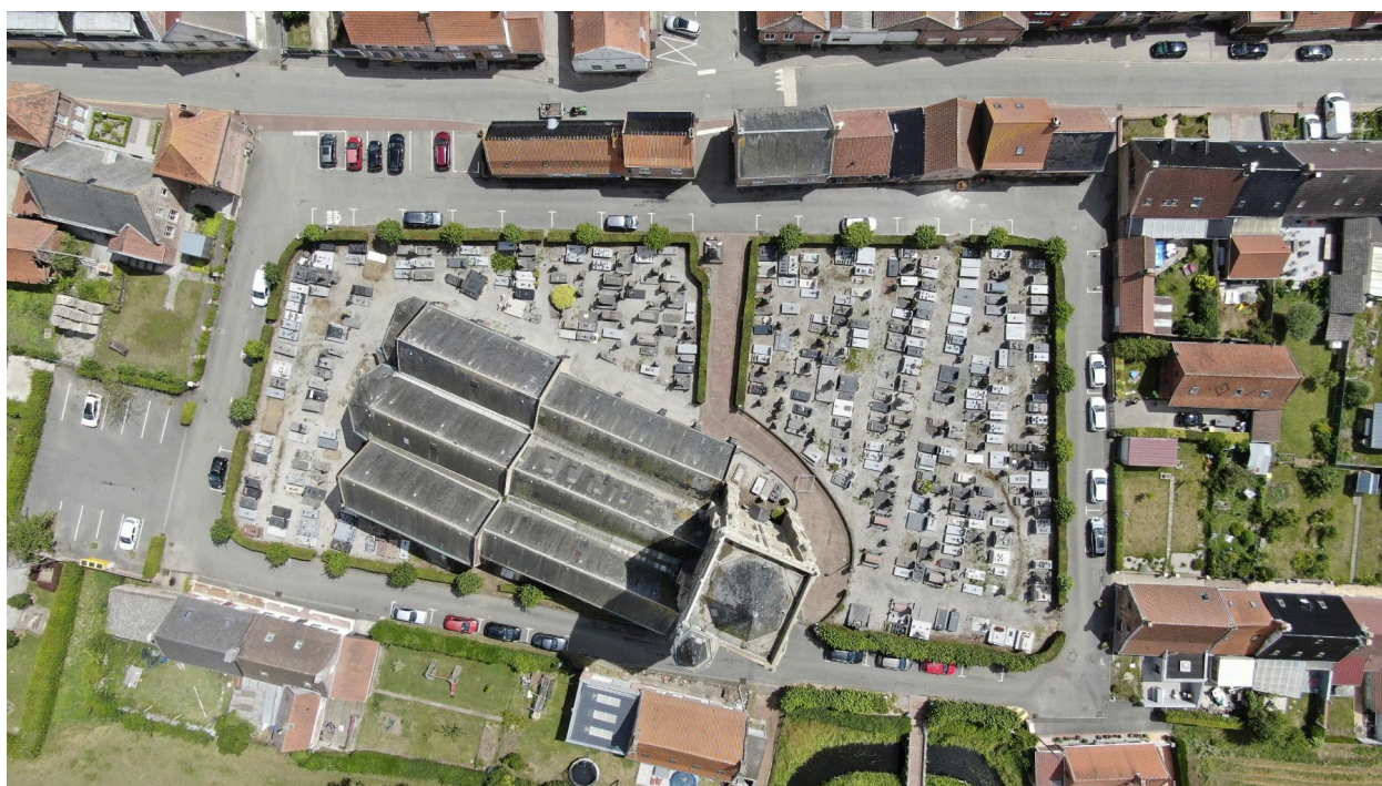
Vue zénithale de l'église.
