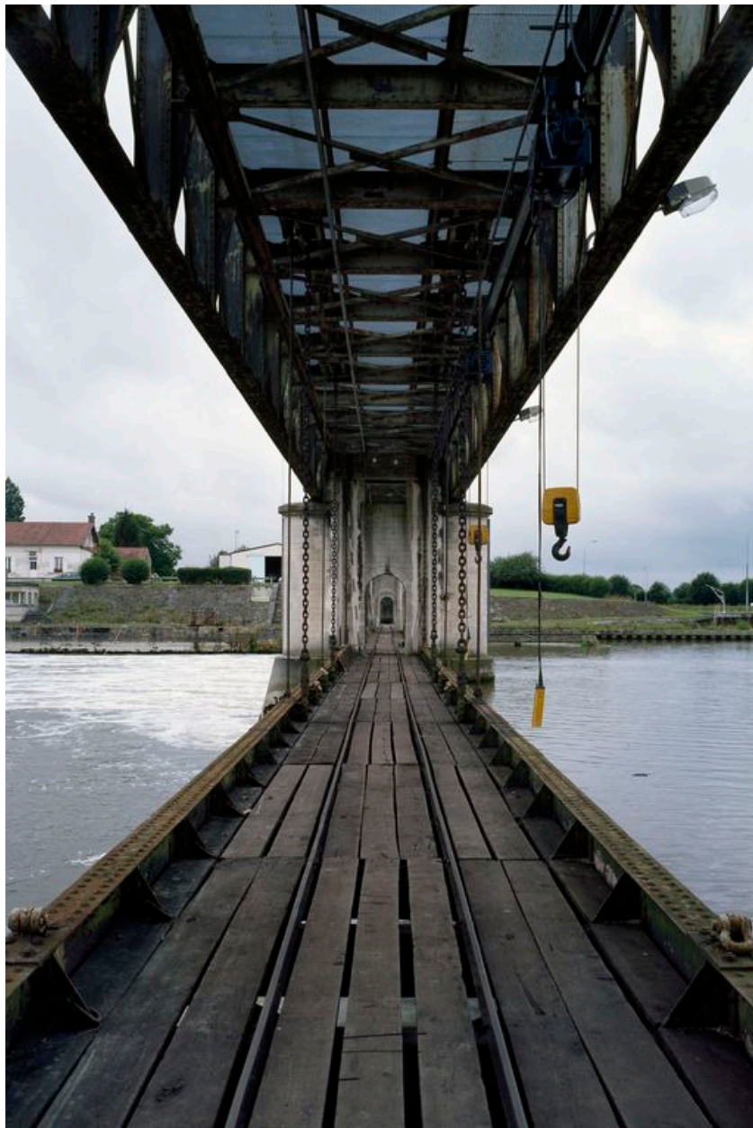
Sarron : passerelle mobile et voie Decauville.
