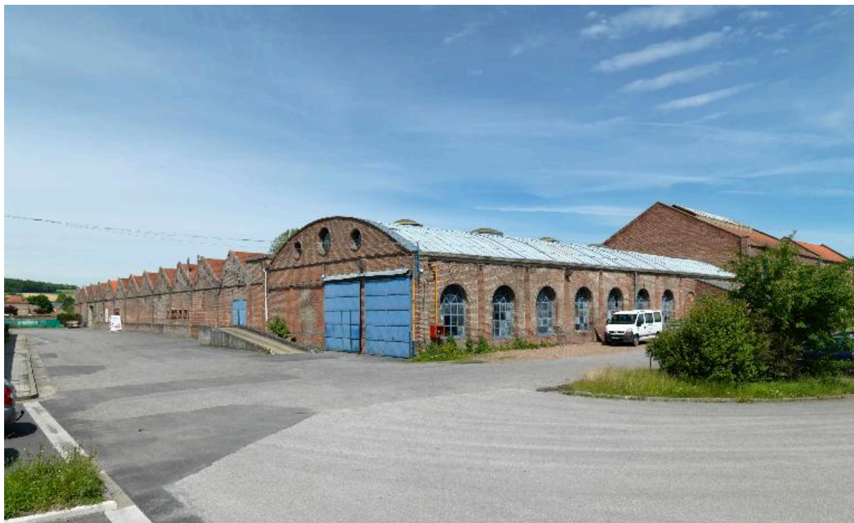
Vue d'ensemble sud-ouest de l'atelier de tissage.
