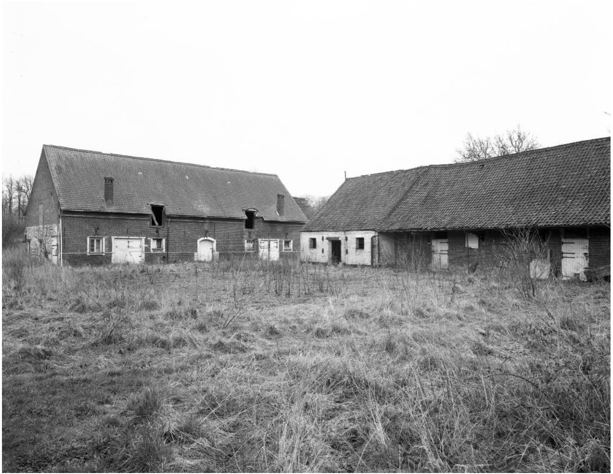
Ferme des Berceaux en 1999 : cour est : les deux vacheries.
