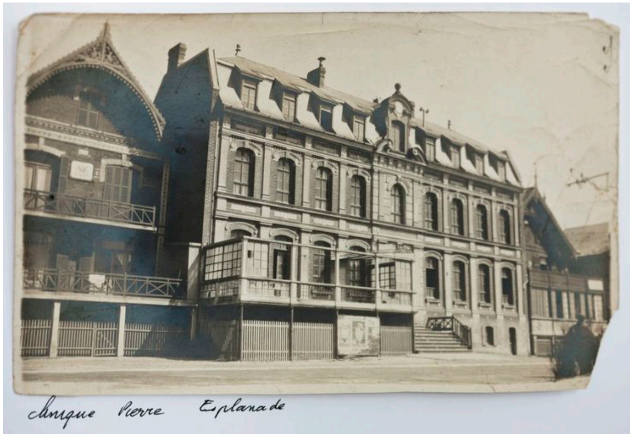
Façade antérieure donnant sur l'esplanade, vue générale prise de trois-quarts gauche. Carte postale, début 20e siècle (coll. part.).
