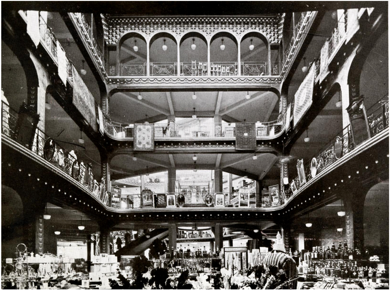
Vue de l'atrium rectangulaire entre 1927 et 1934 (Cité de l'Architecture et du Patrimoine ; fonds des Bétons armés Hennebique ; 3-D-364-e).
