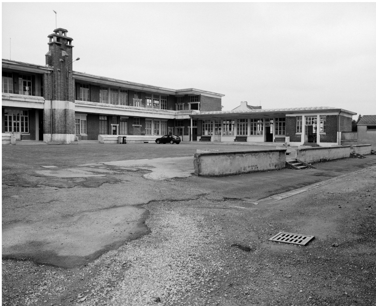
Élévation postérieure partielle et la cour.
