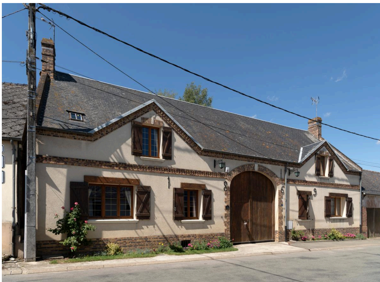
Ancien commerce (?), n°6 rue Tassart, vue depuis le nord-est.
